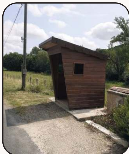
Route des Tulipes avant travaux
