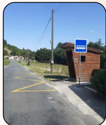
Route des Tulipes après travaux
